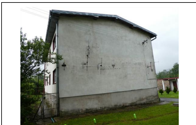
budynek mieszkalny – widok ogólny
