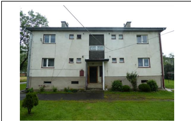
budynek mieszkalny – widok ogólny
