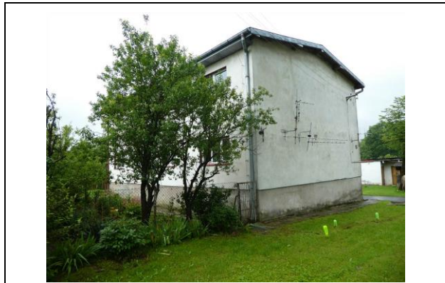
budynek mieszkalny – widok ogólny
