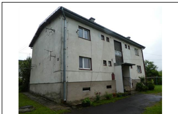
budynek mieszkalny – widok ogólny
